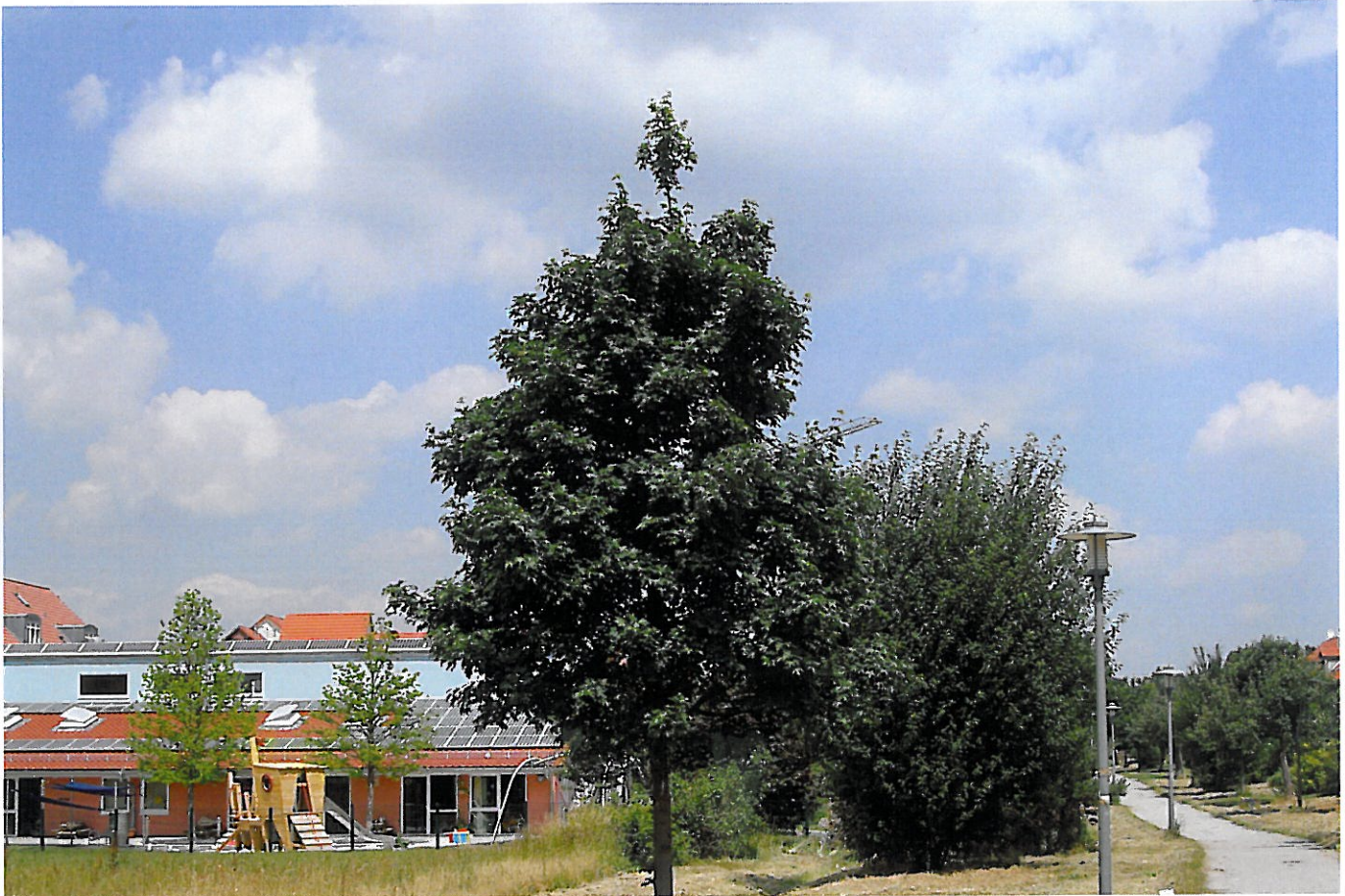
Bild 1. Die Kindertagesstätte im Kiesel-Carrée in Göttingen liegt für alle gut erreichbar im zentralen Grünzug
