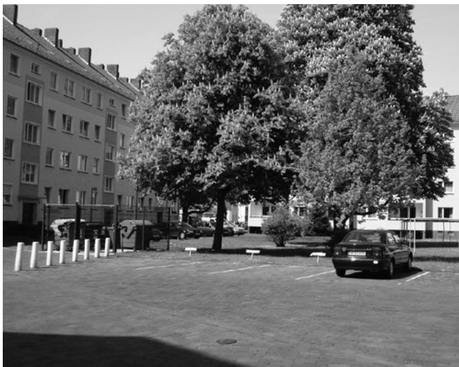
Vorher: Im Zentrum des Quartiers befand sich vorher ein kahler Platz, der durch Poller gegen Durchgangsverkehr geteilt war. Links neben dem großen Baum, der leider weichen musste, sieht man die vorherige Art der eingezäunten Müllplätze.
