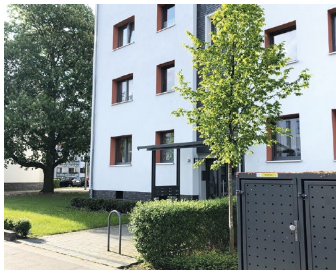
Nachher: Die Gebäude haben attraktive Eingangsbereiche mit Vordächern bekommen, die Müllcontainer sind eingehaust und haben ein Gründach. Ein Heckenstreifen hinter den Fahrradbügeln, eine neue, standortgerechte Sockelbepflanzung und ein kleiner Hausbaum machen den Vorgarten zur Visitenkarte des Hauses.
